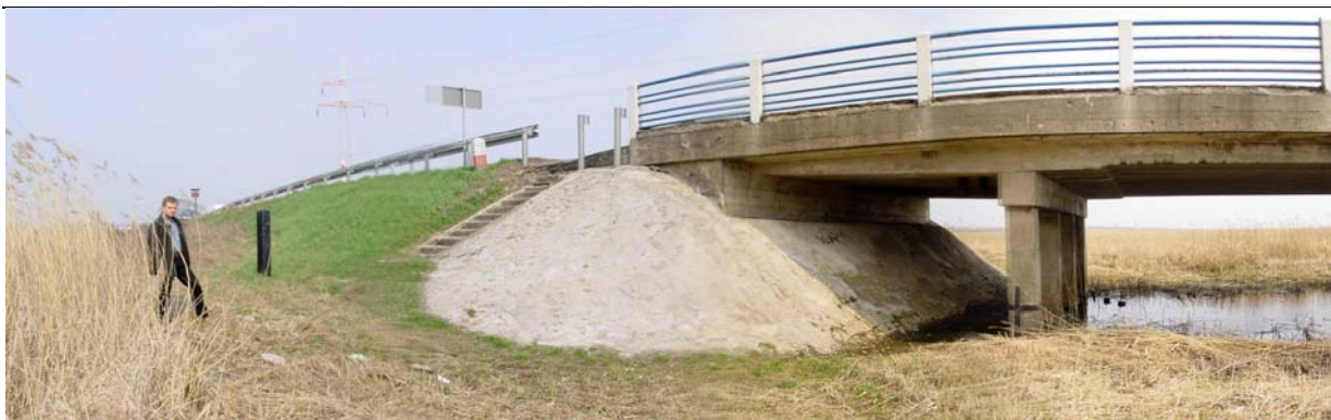
Zdjęcie 15: Istniejący nasyp drogowy i most są dużą przegrodą przestrzenną w Dolinie Biebrzy
